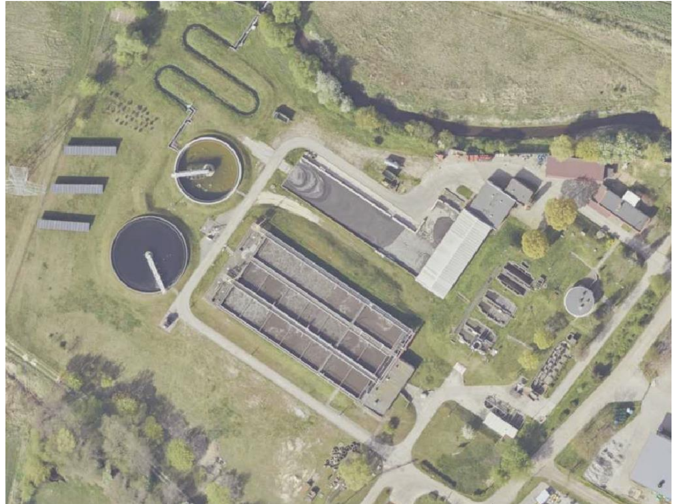
Oczyszczalnia ścieków w Namysłowie
